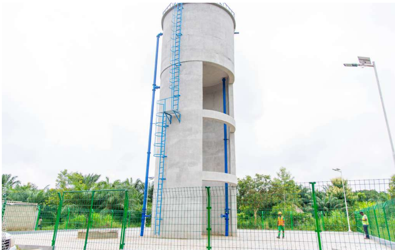
Château d'eau cylindrique de 100 m 3 sur une hauteur sous cuve de 15 m.
