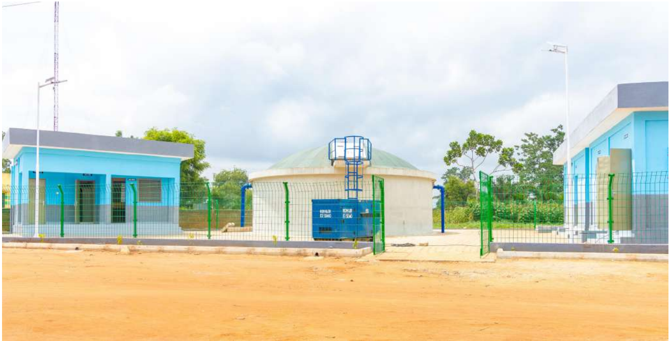
Bâche de reprise et locaux (Technique, Unité de chloration, et Administratif) de la station de pompage.
