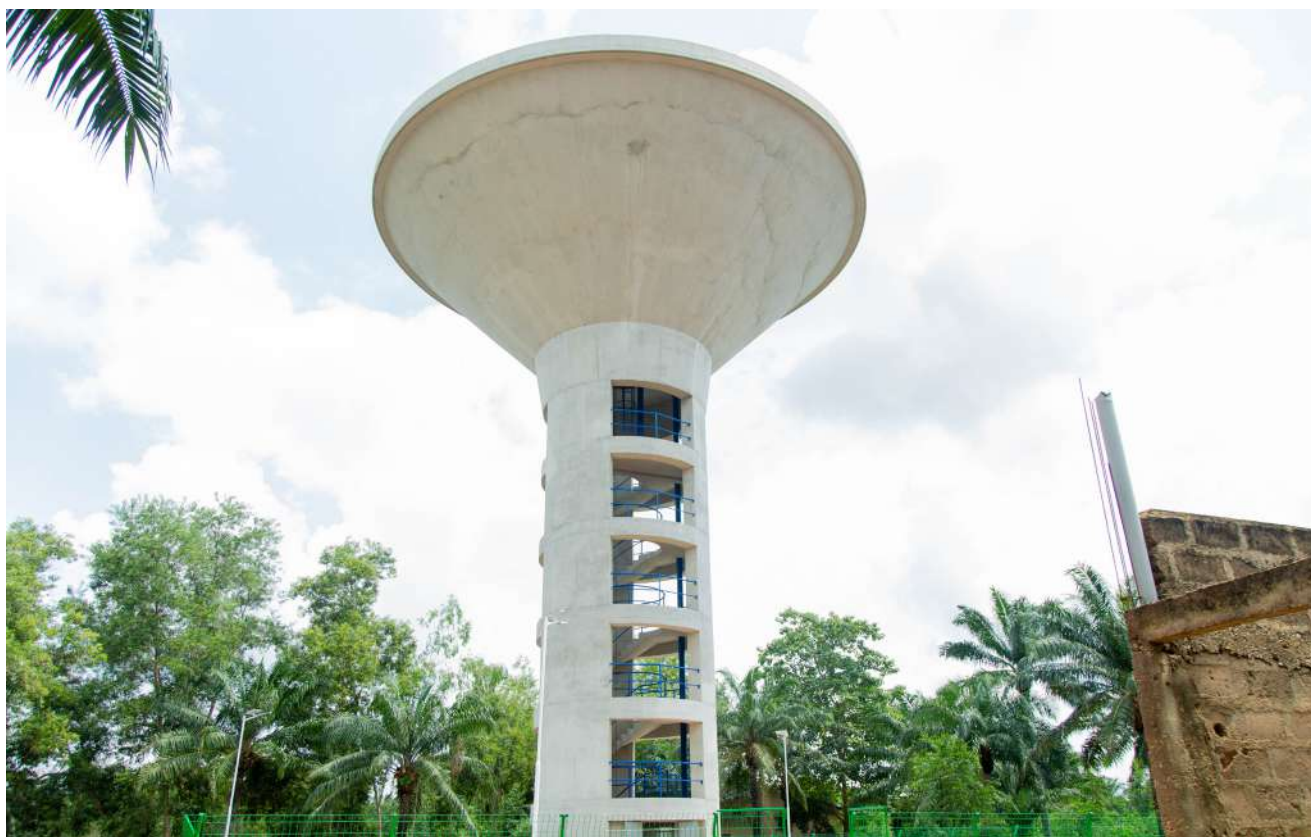
Château d'eau conique de 500 m 3 sur une hauteur sous cuve de 18 m
